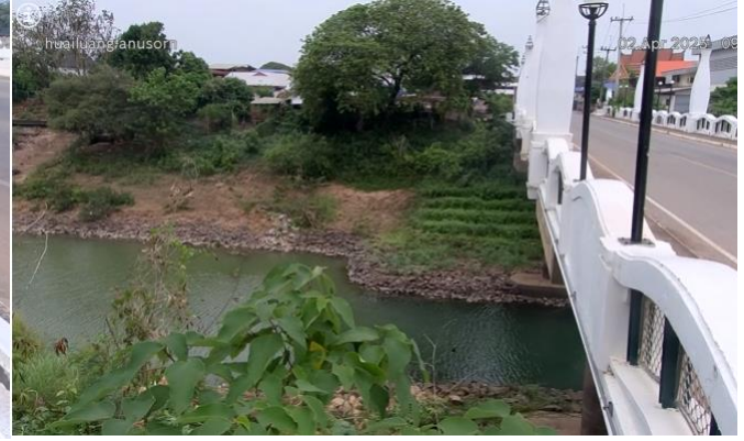
C031703 : สะพานห้วยหลวงอนุสรณ์ ต.จุมพล อ.โพนพิสัย จ.หนองคาย
